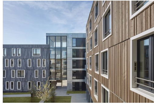
Bild 1 Die drei L-förmigen Gebäudekomplexe des Bochumer Studentenwohnheims wurden in nur 15 Monaten Bauzeit fertiggestellt.
