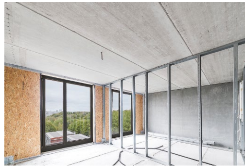
Bild 2 Hoher Vorfertigungsgrad auch beim Wuppertaler Studentenwohnheim
