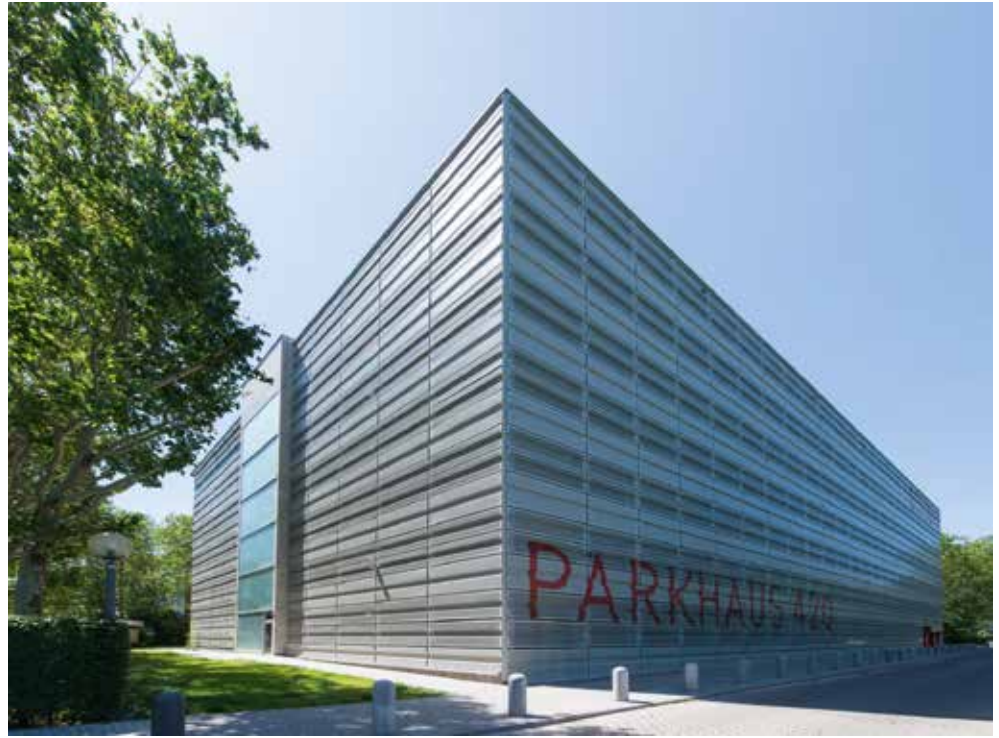
Klar strukturierte Metallfassade wirkt geschlossen, sorgt allerdings innen für viel Licht Fotos: nilo - Agentur für Fotografie GbR
