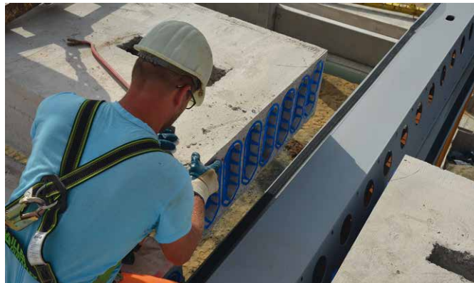
Bild 5 Schnell und schlank: Flachdeckenkonstruktion aus BRESPA®-Decken und PEIKKO DeltaBeam®-Verbundträgern
