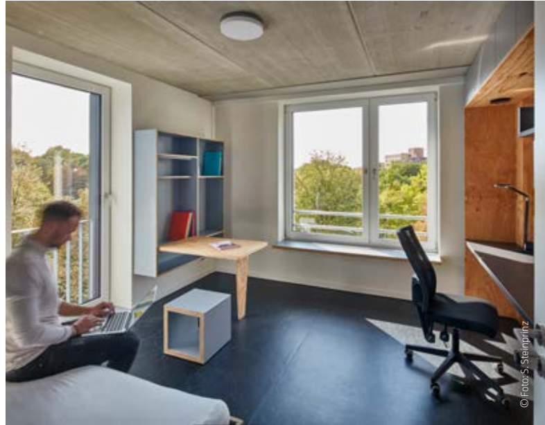
Blick in eine Wohnung mit dem sichtbaren Tragwerk aus Spannbeton-Fertigdecken und deckengleichen Verbundträgern in der Außenwand.
