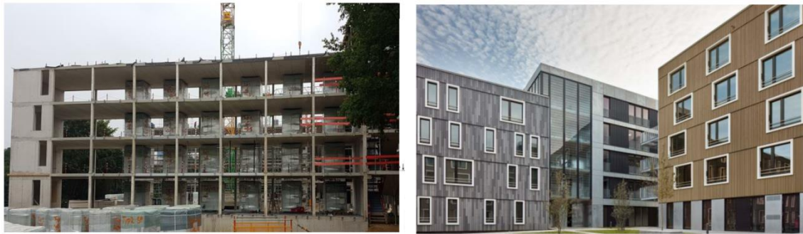
Bild 3-2: Untersuchtes Gebäude im Rohbau und nach der Fertigstellung
