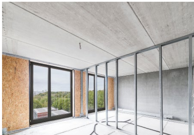
Bild 5. Blick in die Apartments der Studierenden in Wuppertal: große, deckenhohe Fensterflächen lassen „innen“ mit „außen“ verschmelzen, die langen Spannweiten der Spannbeton-Fertigdecken ermöglichen anpassungsfähige Grundrisse (Foto: Thomas Bocian)
