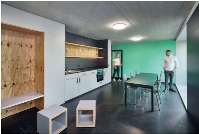
Bild 6. Blick in die Gemeinschaftsküche: Im prämierten Studierendenwohnheim Siepenfeld sind die Spannbeton-Fertigdecken unbehandelt geblieben (Foto: Sigurd Steinprinz)
