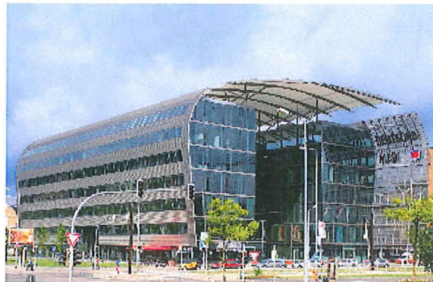
Die Fassade des Projektes – Deutsche MED in Rostock – ist vom Tragwerk entkoppelt. Grafik und Fotos: DW SYSTEMBAU GMBH
