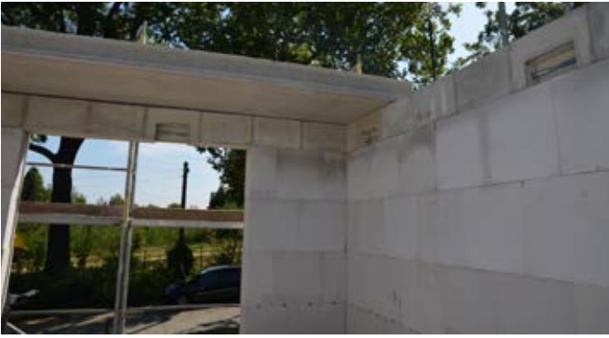
Alle Bauteile sind demontierbar und lassen sich mehrfach einbauen
