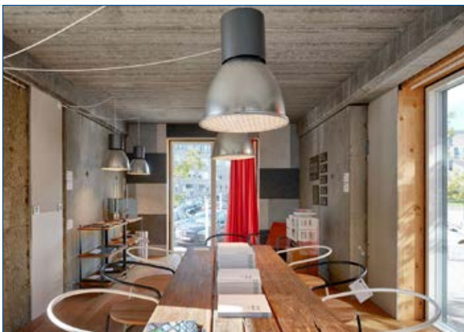
Musterwohnraum mit sichtbaren Spannbeton-Fertigdecken
