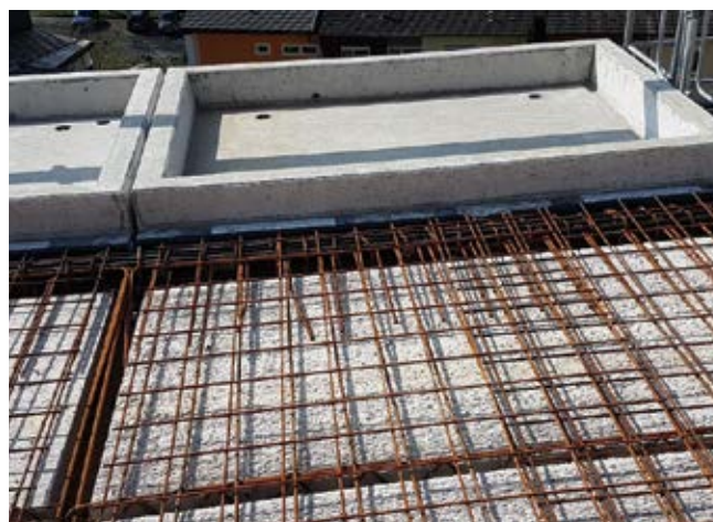
Balkonanbindung mit HALFEN Hit-Elemente
