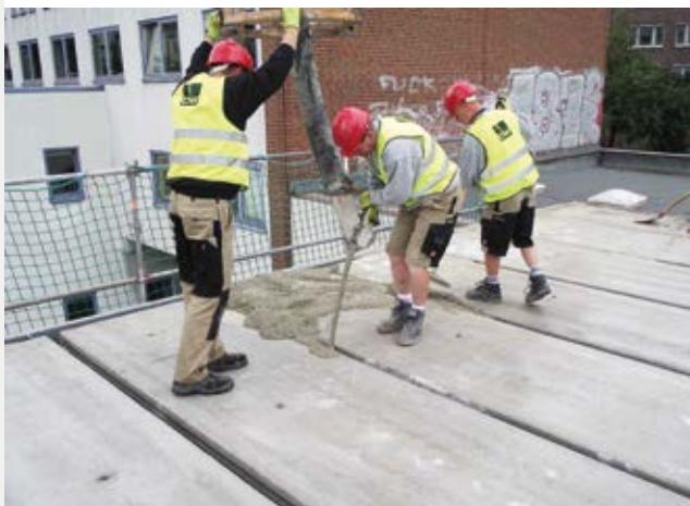
Verguss der Längsfugen
