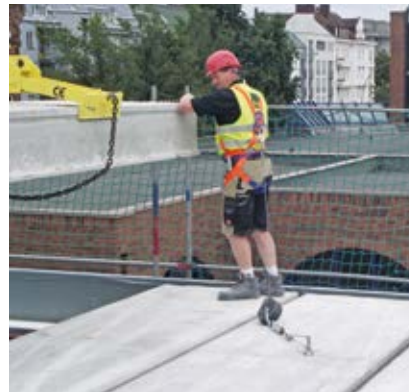
Montage mit Leenstra-Pistolenanker
