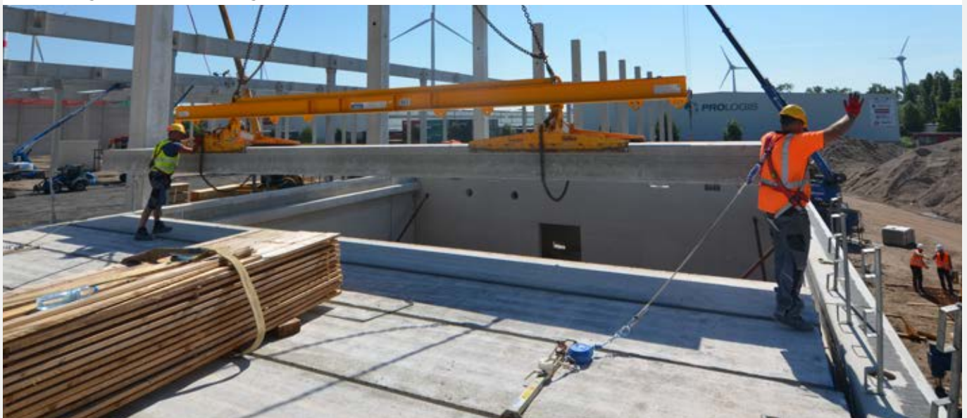
Montage mit Leenstra-Sicherungsklemme
