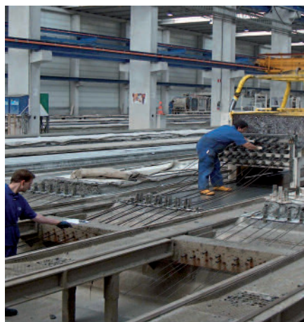
Bild 8: Einfädeln des Spannstahls
