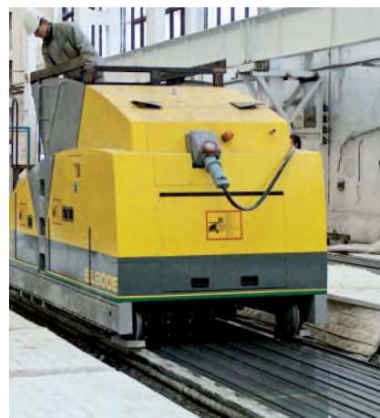
Bild 9: Extruderfertiger im Einsatz
