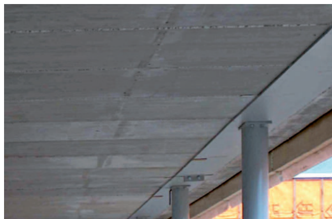
Bild 20: Slim Floor-Auflagerung
