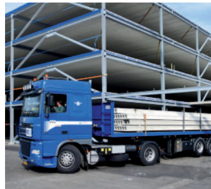
Bild 6: Parkhaus in Köln
