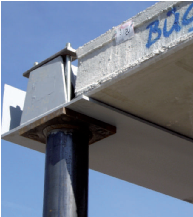
Bild 17: Randträger als Slim Floor – Auflager
