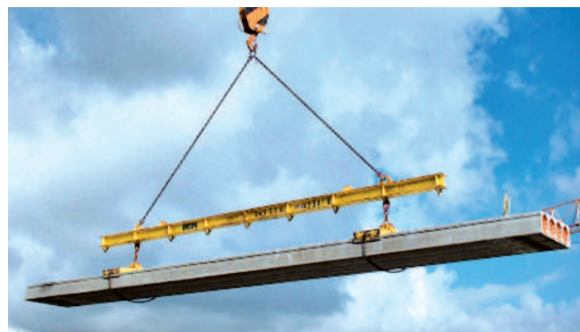
Bild 1: Montage von Spannbeton-Fertigdecken
