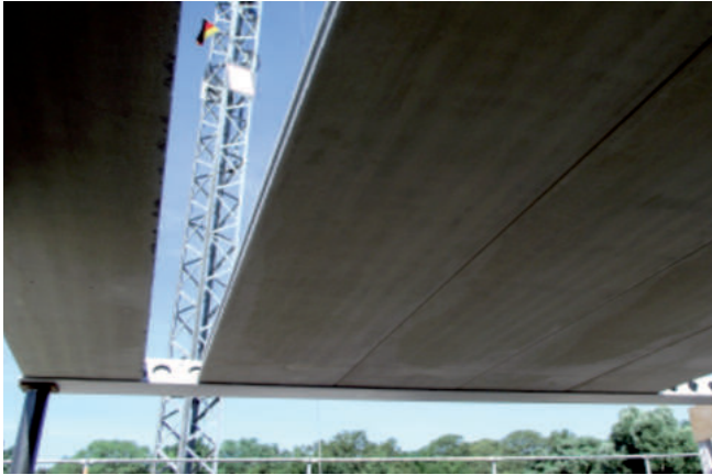
Bild 16: Sichtkontrolle von unten
