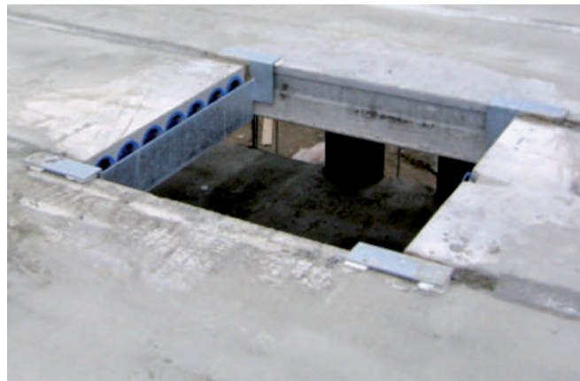
Bild 19: Für größere Öffnungen werden Stahlwechsel mitgeliefert
