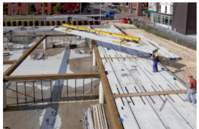
Bild 15: Deckenmontage in deckengleichen Stahlträgern
