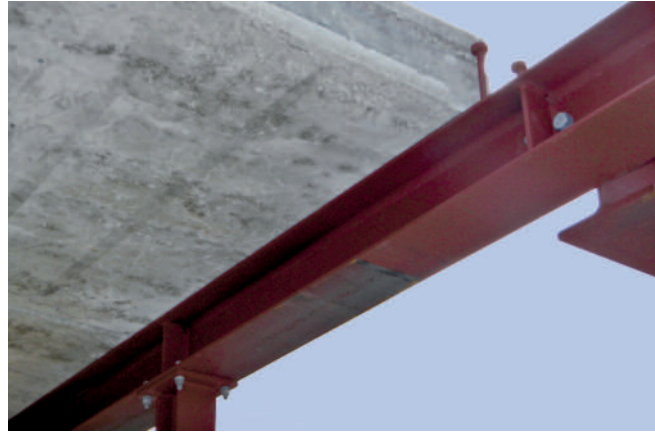
Bild 18: Träger mit Kopfbolzen zur Ringankerwirkung
