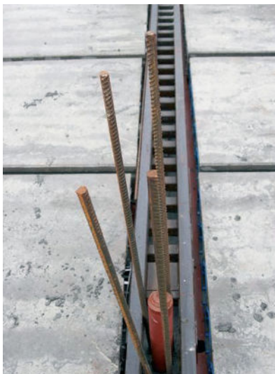
Bild 3. Deckenauflagerung auf SWT-Trägern im unvergossenen Zustand
