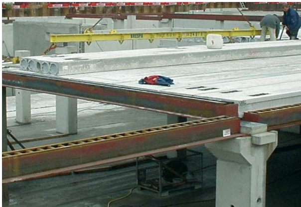
Bild 5. Montagezustand: BRESPA-Decken auf SWT-Trägern
