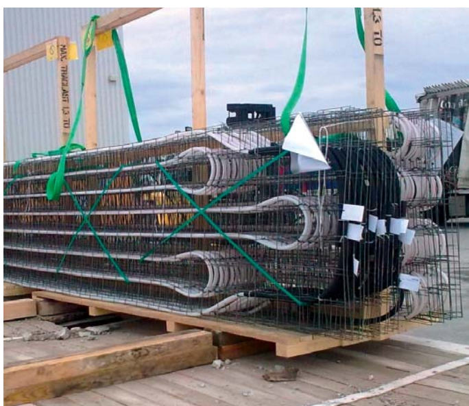
Die Rohrregister werden fix und fertig angeliefert.
