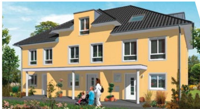
Moderne Mehrfamilienhäuser in Düsseldorf-Angermund
