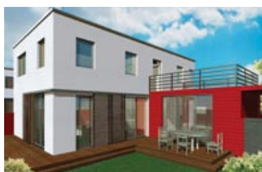
Die Passivhauswohnanlage „Seelhorst Park“ am Rande von Hannover wurde mit BRESPA-Decken errichtet
