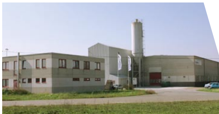
Das neue BRESPA-Werk in Luckau
