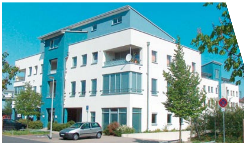
Architektur mit Nadelstreifen: Sichtbare Deckenfugen alle 1,20 m
