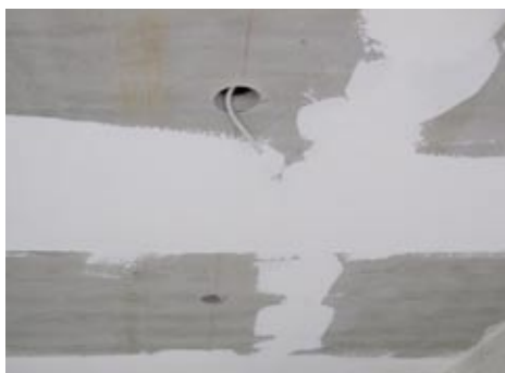
Gespachtelte Decke vor dem Tapezieren
