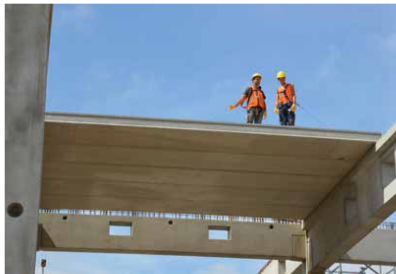
Just in Time – Montagen mit BRESPA® -Decken: 5.900 m 2 wurden aus dem Werk Schneverdingen auf die IKEA-Baustelle nach HH-Altona geliefert
