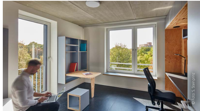
Blick in eine Wohnung mit dem sichtbaren Tragwerk aus Spannbeton-Fertigdecken und deckengleichen Verbundträger in der Außenwand
