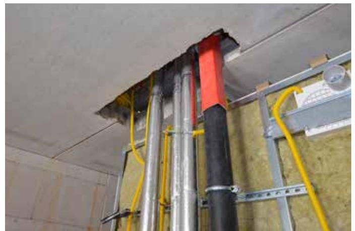
Der hohe Grad an Vorfertigung sorgt für einen schnellen Baufortschritt und reduziert Schnittstellen und Fehlerquellen auf der Baustelle: Nasszellen werden mit kompletter Ausstattung angeliefert und die **BRESPA**®-Decken werden bereits im Werk mit allen notwendigen Aussparungen hergestellt.
