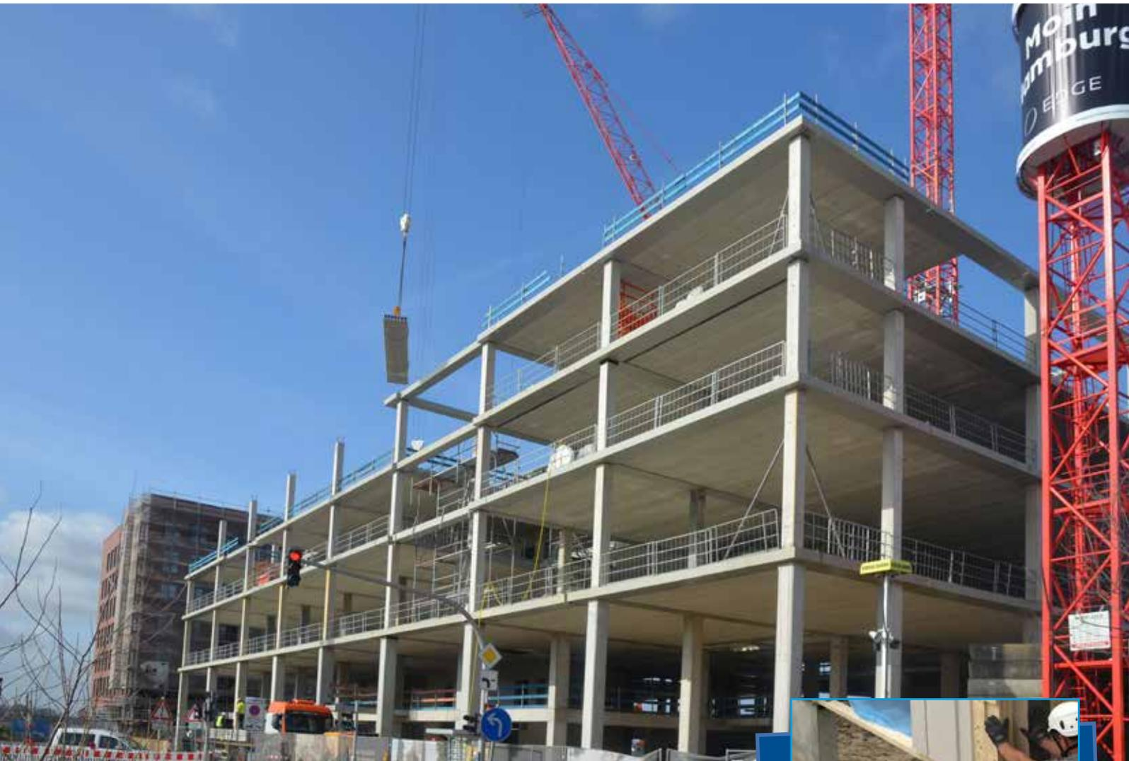
Am Osteingang zur HafenCity in Hamburg entsteht derzeit mit dem 18-geschossigen EDGE Elbside das höchste Bürogebäude mit **BRESPA**®-Decken in Deutschland. 20.000 m<sup>2</sup> mit bis zu 9,29 m langen Deckenelementen in einer Deckenstärke von 26,5 cm sorgen für stützenfreie und anpassungsfähige Geschossflächen.
