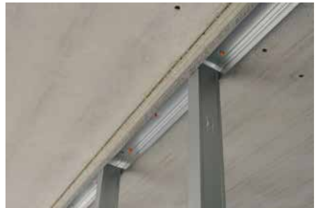
Anzeichnen der Bohrlöcher und Trennwandprofile mit Nägel befestigt.
