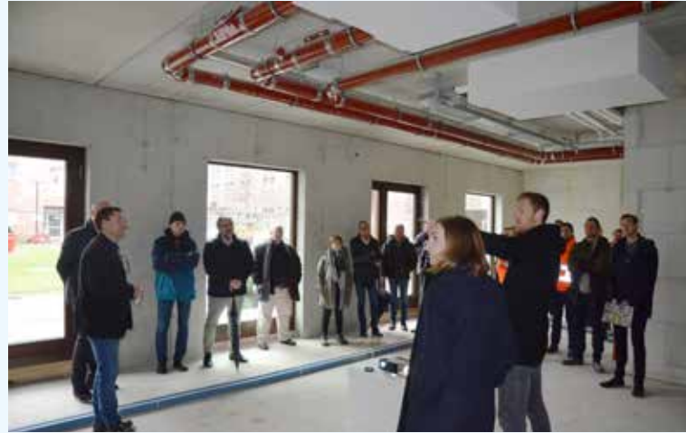
BIM-Präsentation durch Architekt Jens Merkel und Bauleiter Jakob Thomsen (beide HOCHTIEF Infrastructure GmbH) und Julia Intelmann (Architekturbüro limbrock & tubbesing; Personen im Vordergrund)
