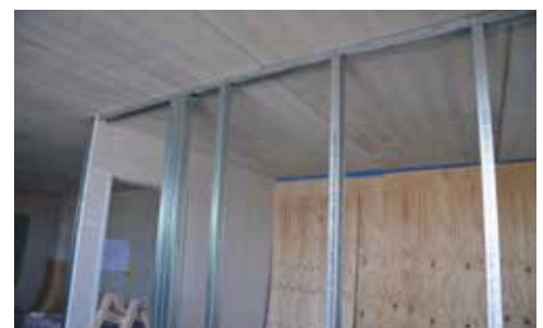
Dank der BRESPA® -Decken können alle Innenwände nicht-tragend ausgeführt werden.
