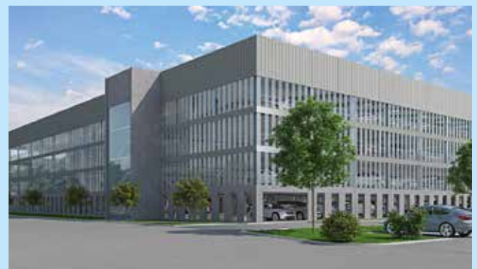
Quelle: Willy Johannes Bau GmbH & Co. KG
