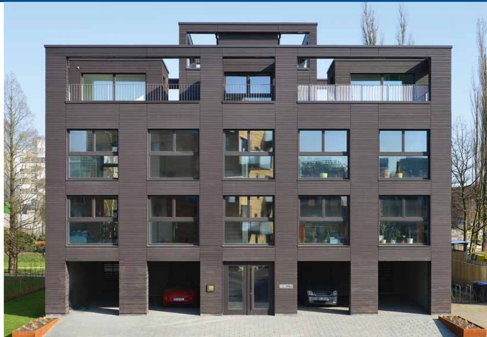
Modulare Tragwerke aus Spannbeton-Fertigdecken und vorgefertigten Betonwänden – jede Wohneinheit stellt ein freies Regelfach dar – bedeuten kurze Bauzeiten und größtmögliche Flexibilität (Ausbauhaus Neukölln, Praeger und Richter Architekten, Berlin).
