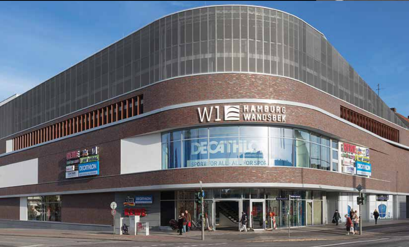
EKZ Wandsbeker Marktstr. 1 mit drei Parkebenen über den Geschäftsetagen. Fast 6.000 m 2 BRESPA®-Decken mit Längen bis zu 16 m wurden im W1 eingebaut.
