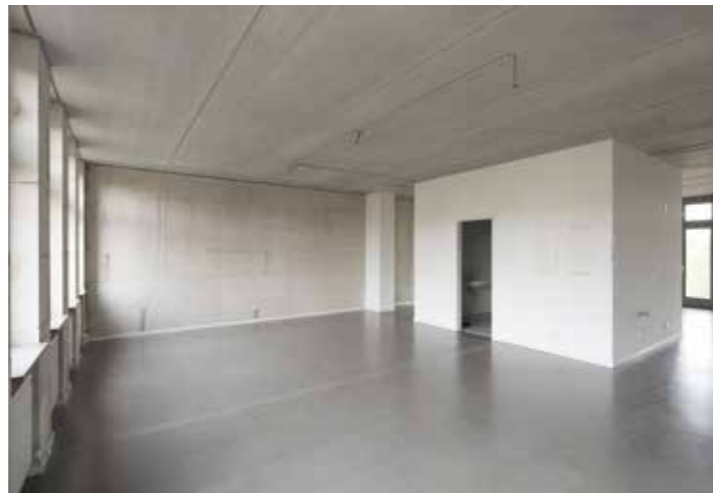
Modulare Tragwerke aus Spannbeton-Fertigdecken und vorgefertigten Betonwänden – jede Wohneinheit stellt ein freies Regelfach dar – bedeuten kurze Bauzeiten und größtmögliche Flexibilität (Ausbauhaus Neukölln, Praeger und Richter Architekten, Berlin).
