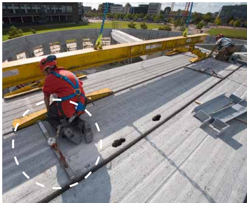
LEENSTRA-Sicherungsklemmen lassen sich einfach umsetzen
