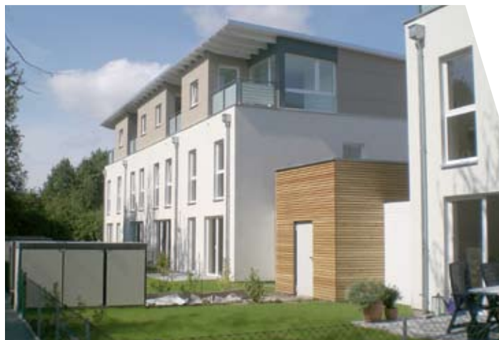
Passivhäuser im Eco-Carré in Hannover sind mit Photovoltaik-Dachbahnen ausgestattet und der gemeinschaftliche Quartiersplatz wird solar beleuchtet.
