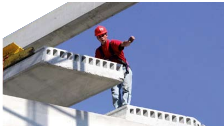
Einfache Montage durch Vorfertigung im Werk.
