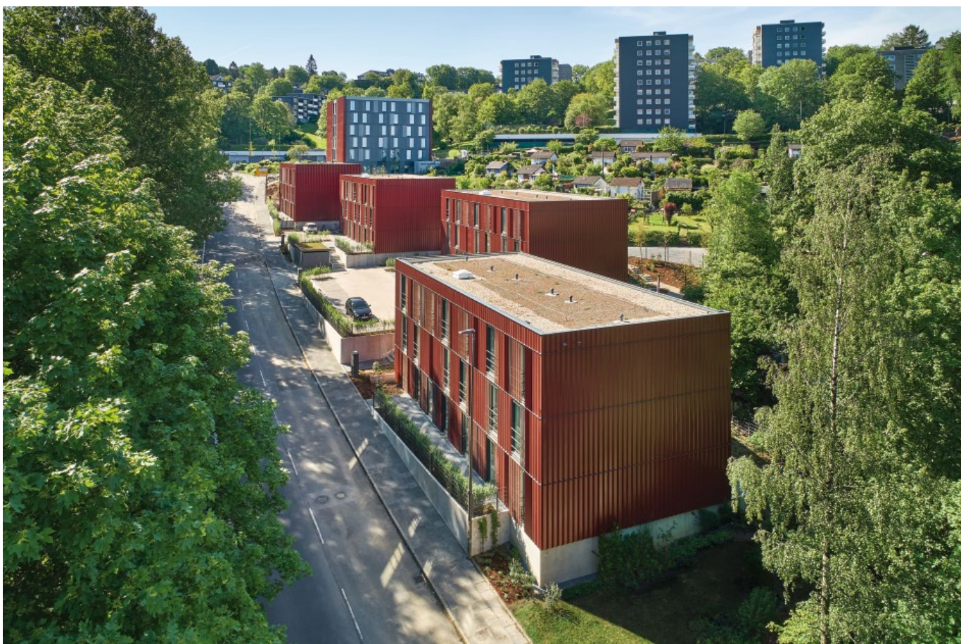
Bild 4. Vier 3-geschossige Zeilenhäuser im Vordergrund und ein Punkthaus im Hintergrund bieten 132 Studierenden der Bergischen Universität Wuppertal moderne Unterkünfte in Holz-Beton-Hybridbauweise. Die großen Spannweiten der BRESPA®-Decken erlauben variable Trennwände und das Zusammenlegen der Zimmer für andere Nutzungen.
