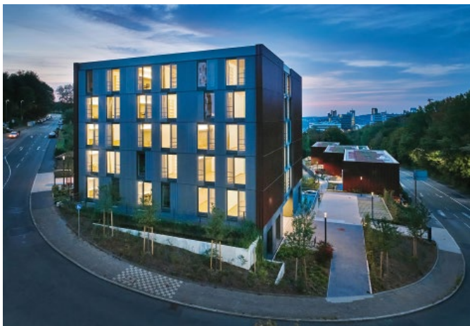
Bild 3. Die fünf Studierendenwohnheime für die Bergische Universität Wuppertal wurden von ACMS Architekten aus Wuppertal entworfen: vorgehängte, austauschbare Holzfassaden und 4.350 m 2 BRESPA®-Decken als Geschoss- und Dachdecken sorgen neben einer kurzen Bauzeit auch für einen verantwortungsvollen Materialeinsatz; das Projekt wurde von Forschungsinitiative Zukunft Bau als „herausragendes Modellvorhaben“ eingestuft (Foto: Sigurd Steinprinz)
