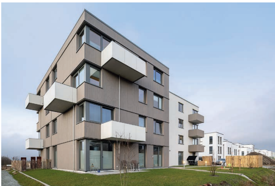
Bild 7. Ansprechende Architektur zu kostengünstigen Konditionen: Das Wohnprojekt „Nordkante“ der Gebr. Schütt KG im Süden Hamburgs ist ein Holz-Beton-Hybridbau mit 15 Eigentumswohnungen, für das DW SYSTEMBAU ca. 1.200 m 2 Geschosdecken Hohl- und Massivdecken geliefert hat (Foto: Thorsten Scherz)
