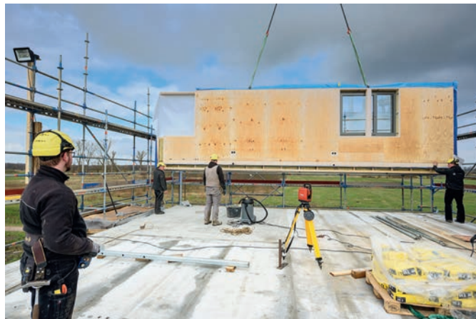
Bild 8. Geschosshohe vorgefertigte Holzwandelemente der Gebr. Schütt KG werden für das Wohnprojekt „Nordkante“ in einem Stück montiert (Foto: Thorsten Scherz)
