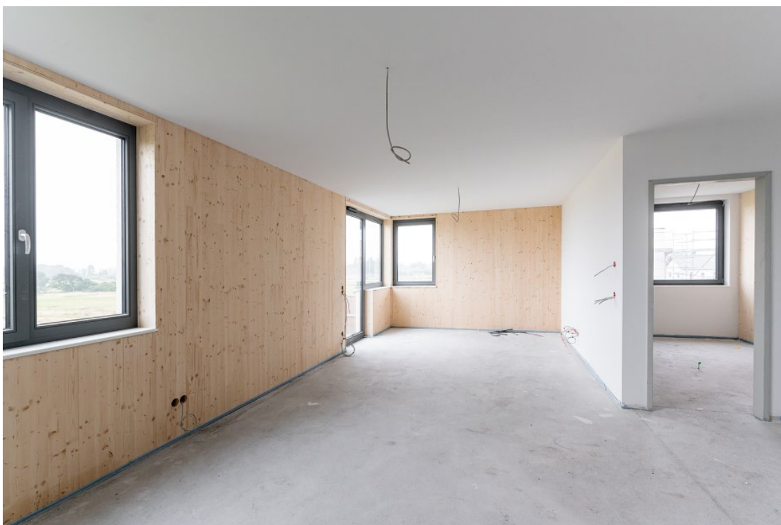
Bild 2. Fertig zur Übergabe: Blick in eine der Eigentumswohnungen im Wohnprojekt „Nordkante“ (Foto: Thorsten Scherz)
