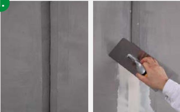
Die zu armierende Fuge gemäß VOB, Teil C, DIN 18363 bzw. BFS-Merkblättern vorbereiten. Die V-Fuge mit geeignetem Füllspachtel oberflächenbündig verfüllen.
