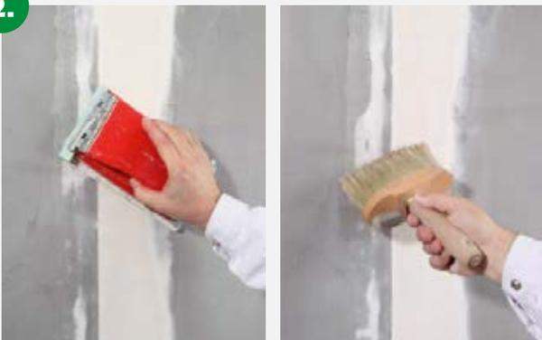
Nach der Durchtrocknung der Feinspachtelung den Fugenbereich schleifen und lösemittelfrei grundieren.
