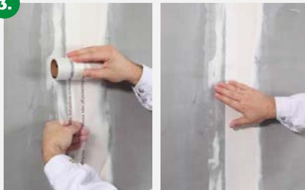
KOBAU optitape SH dem Fugenverlauf folgend fixieren und mit der Hand falten- und blasenfrei andrücken. Achten Sie darauf die Folie auf der Rückseite zu entfernen.
