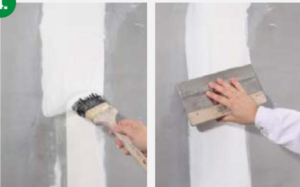
KOBAU Armierungskleber mit dem Pinsel gewebeabdeckend satt auftragen und mit einem breiten Flächen- oder Gummirakel auf Gewebestärke abziehen.
