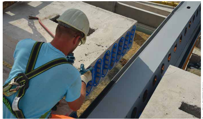
Bild 5 Schnell und schlank: Flachdeckenkonstruktion aus BRESPA®-Decken und PEIKKO DeltaBeam®-Verbundträgern
