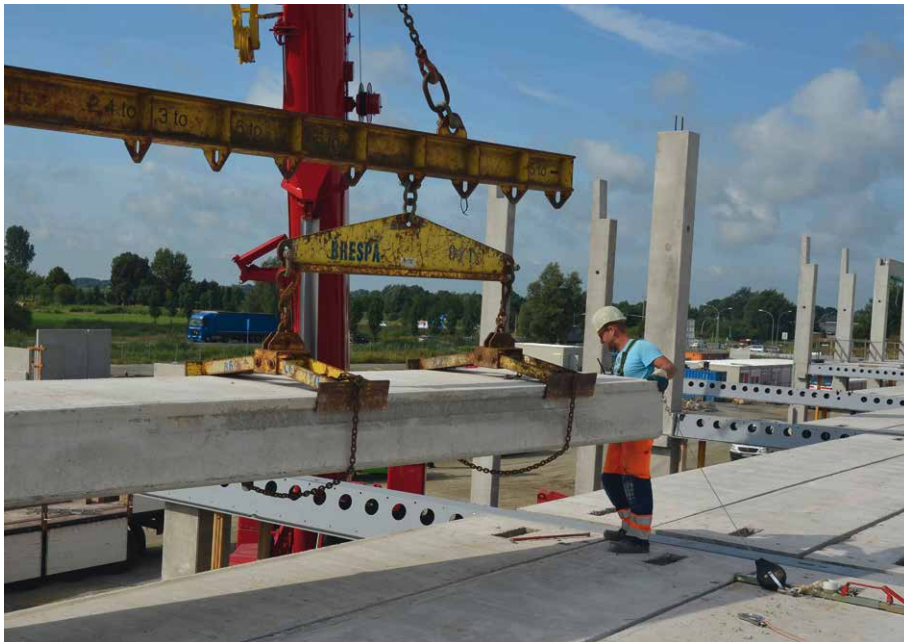
Foto: DW SYSTEMBAU
