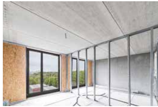
Bild 2 Hoher Vorfertigungsgrad auch beim Wuppertaler Studentenwohnheim
