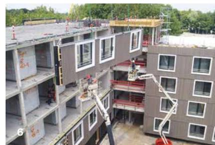
**4** Um das Gebäude später einfacher umnutzen zu können, setzten die Architekten auf ein Spannbeton-Hohldeckensystem, sodass die Räume mit möglichst wenig Stützen auskommen. Die Fertignasszellen werden über eine Transportbühne eingebracht und im Anschluss geschossweise positioniert.
