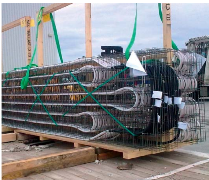
Die Rohrregister werden fix und fertig angeliefert.
