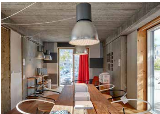
Musterwohnraum mit sichtbaren Spannbeton-Fertigdecken
